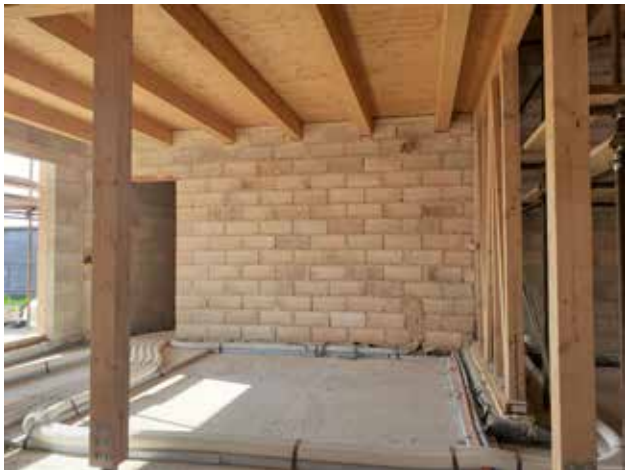
Cloison intérieure de séparation en Biomattone®
