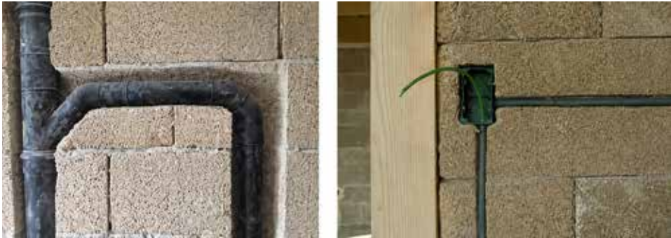
Saignée sur Biomattone® pour installation sanitaire Saignée sur Biomattone® pour installation électrique
