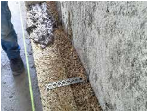
Contre-cloison en Biomattone® avec lame d'air remplie de Biobeton
