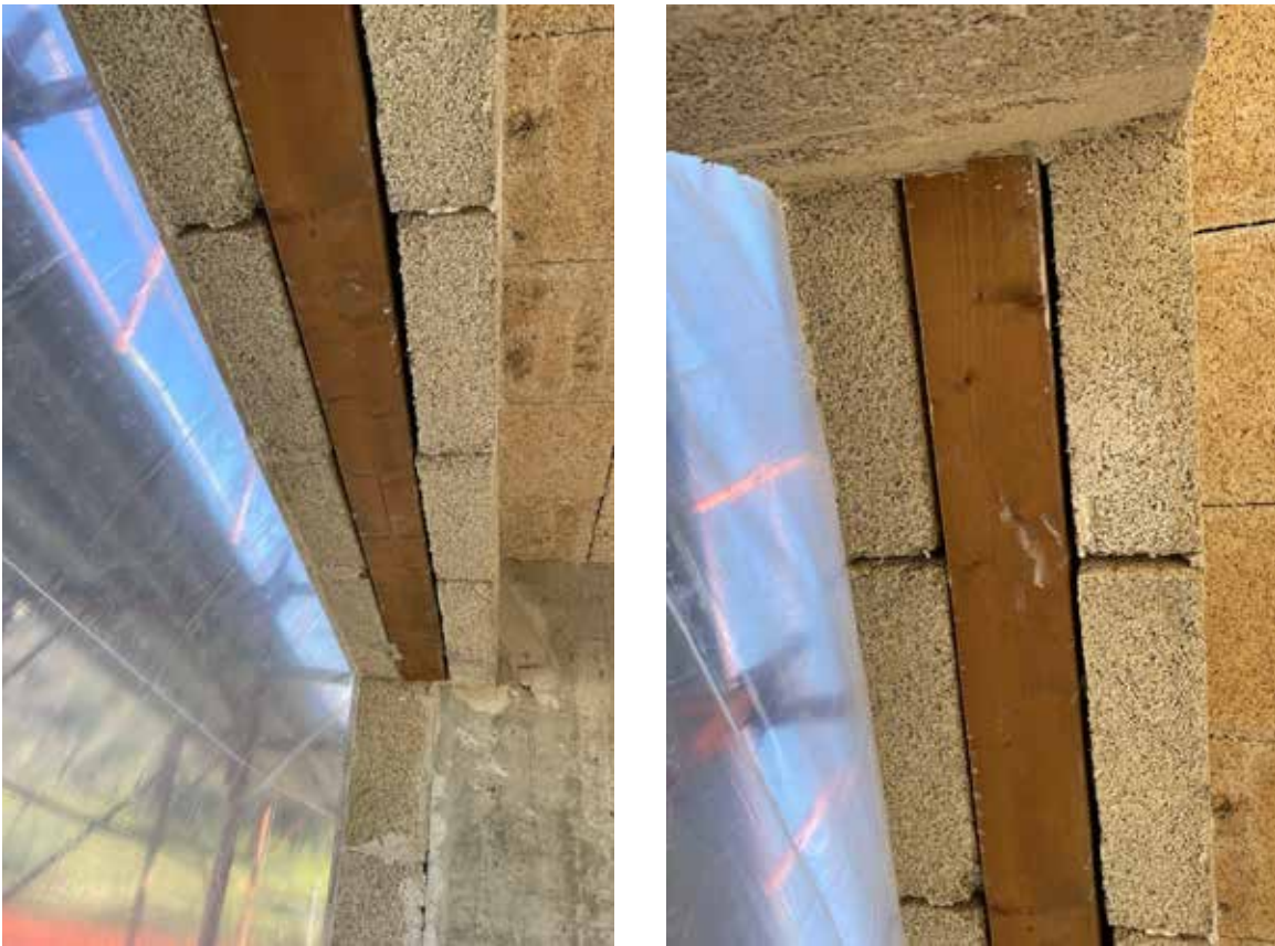
Pose d'un linteau en bois séché sur un mur en Biomattone® avec pont thermique résolu
