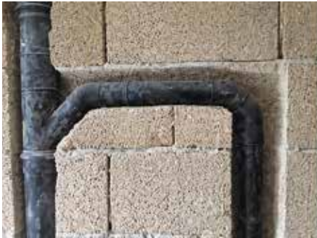
Roza en Biomattone® para instalación sanitaria
