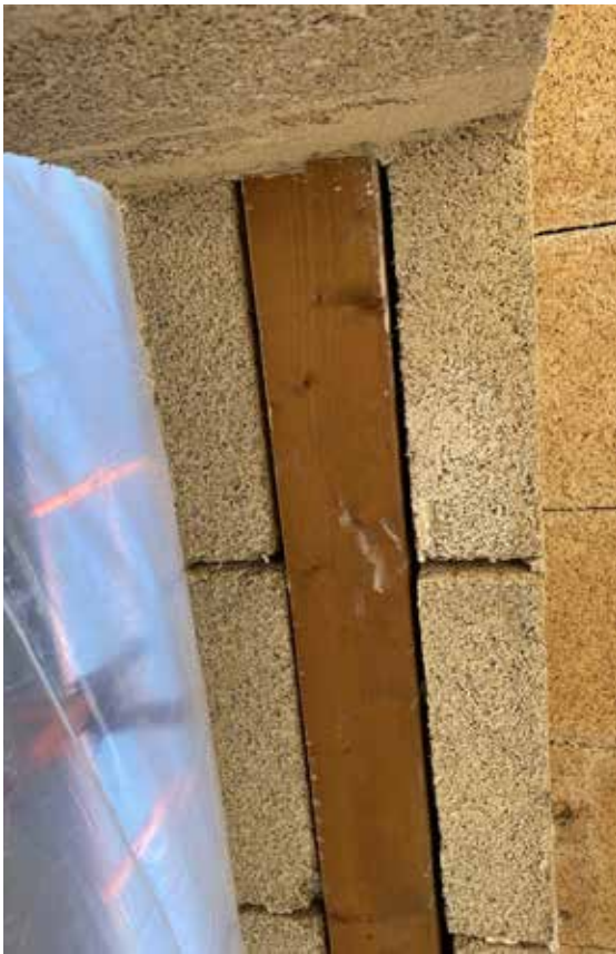
Colocación de dintel de madera seca sobre pared de Biomattone® con puente térmico resuelto
