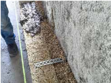
Contramuro de Biomattone® con cámara rellena de Biobeton
