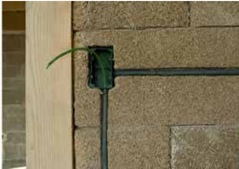
Roza en Biomattone® para instalación eléctrica
