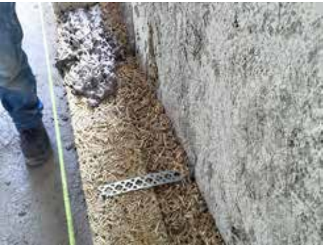
Vorsatzschale aus Biomattone® mit Hohlraum, gefüllt mit Biobeton
