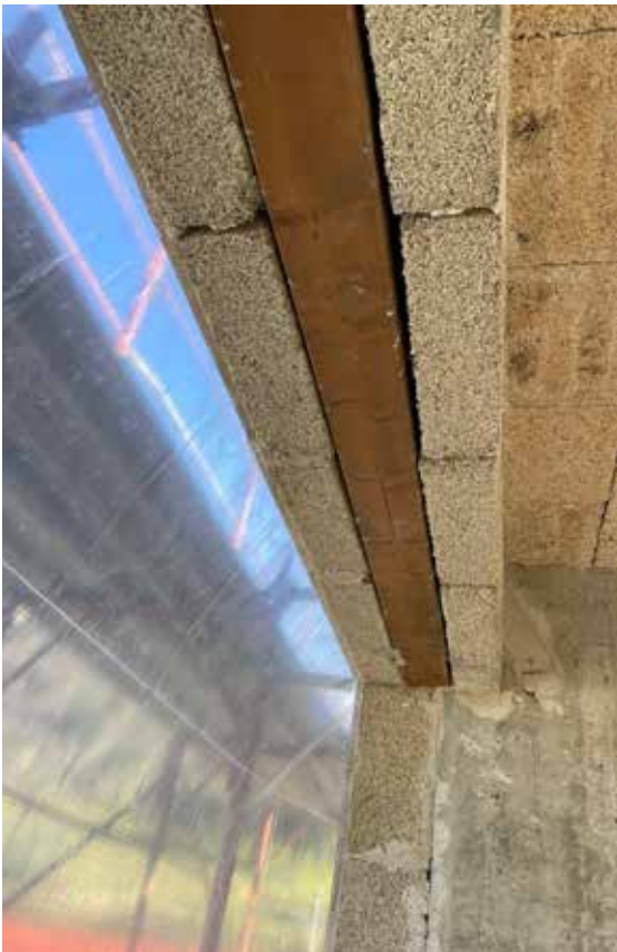
Verlegung eines Sturzes aus kammergetrocknetem Holz auf einer Wand aus Biomattone® mit gelöster Wärmebrücke
