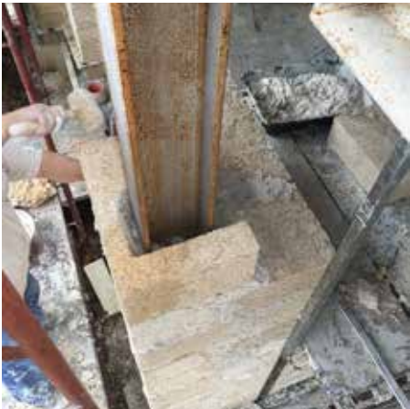
Geformter Biomattone® zur Lösung einer Wärmebrücke am Tragrahmen
