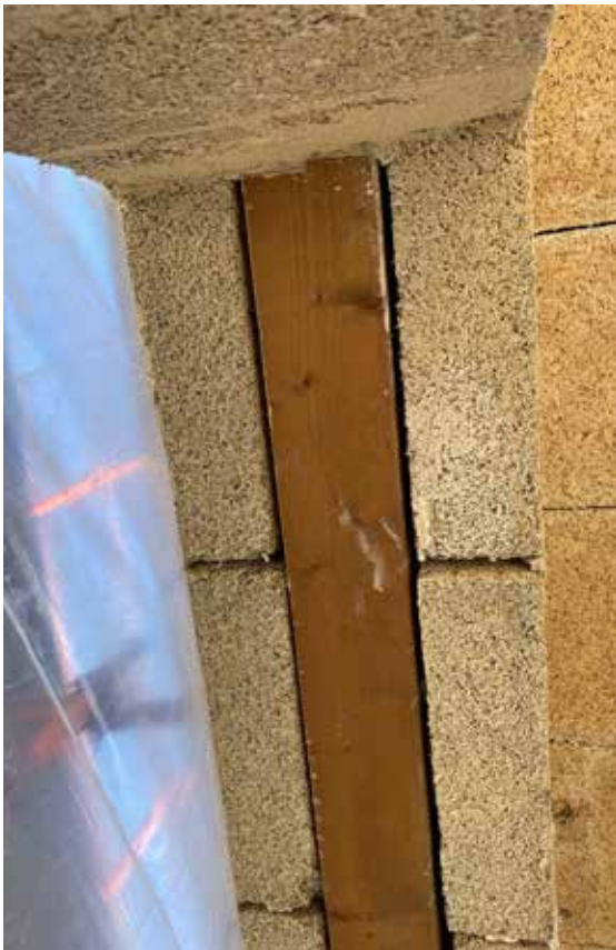
Verlegung eines Sturzes aus kammergetrocknetem Holz auf einer Wand aus Biomattone® mit gelöster Wärmebrücke
