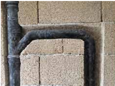
Schlitz im Biomattone® für Sanitärinstallation
