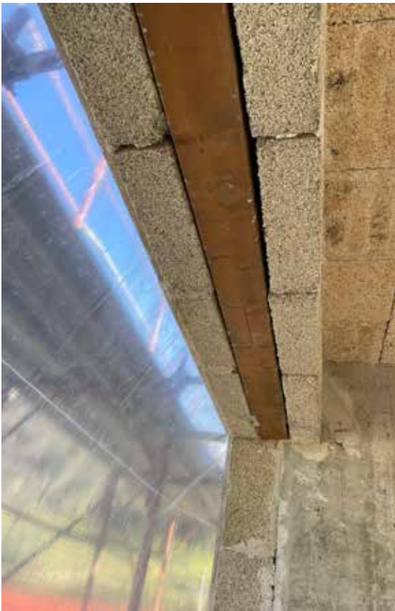
Posa in opera di architrave in legno essiccato su parete in Biomattone® con ponte termico risolto
