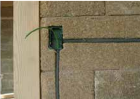
Traccia su Biomattone® per impianto elettrico
