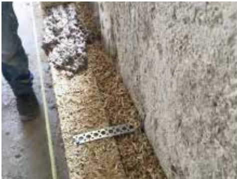
Controparete in Biomattone® con intercapedine riempita in Biobeton
