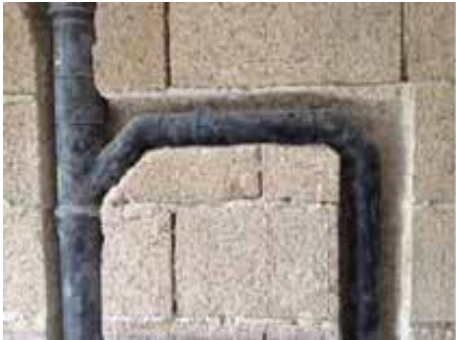
Traccia su Biomattone® per impianto sanitario
