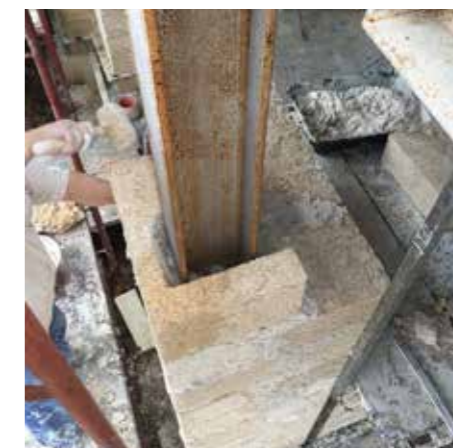
Biomattone® sagomato impiegato per risolvere ponte termico in corrispondenza del telaio strutturale
