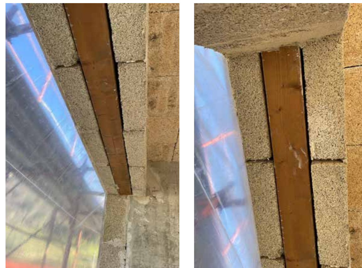
Posa in opera di architrave in legno essiccato su parete in Biomattone® con ponte termico risolto
