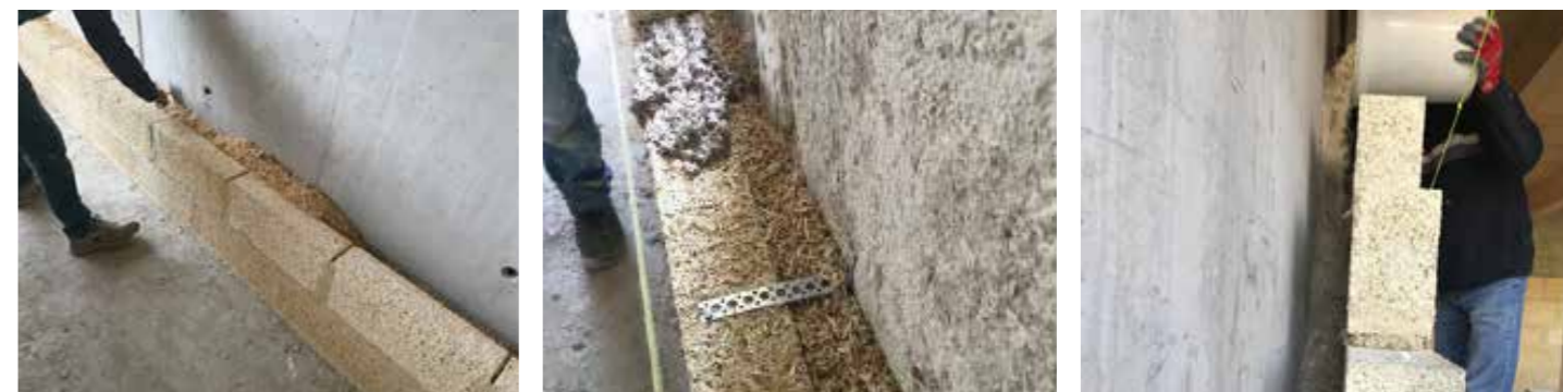
Controparete in Biomattone® con intercapedine riempita in Biobeton
