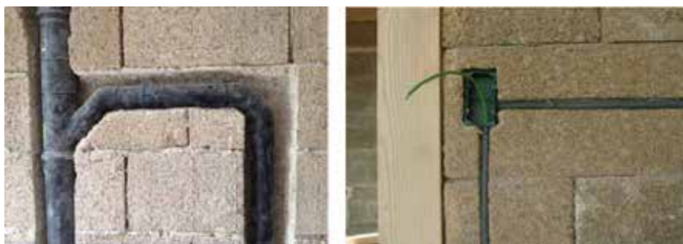
Traccia su Biomattone® per impianto sanitario
