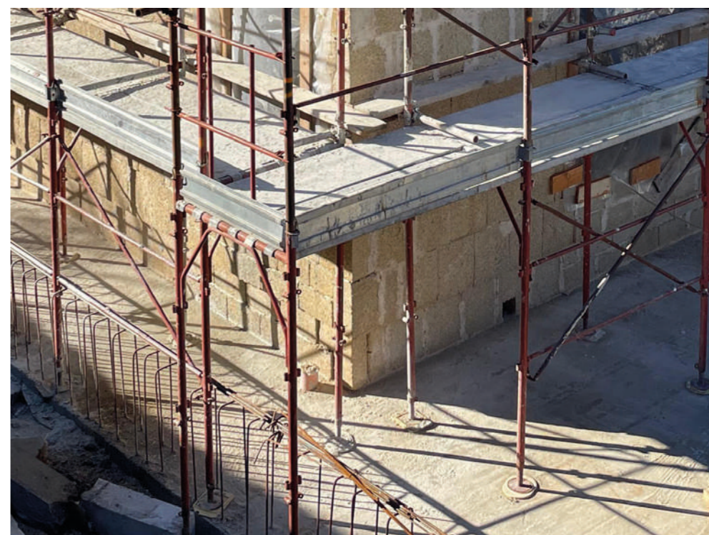
Isolamento del primo corso di Biomattone® con guaina impermeabile
