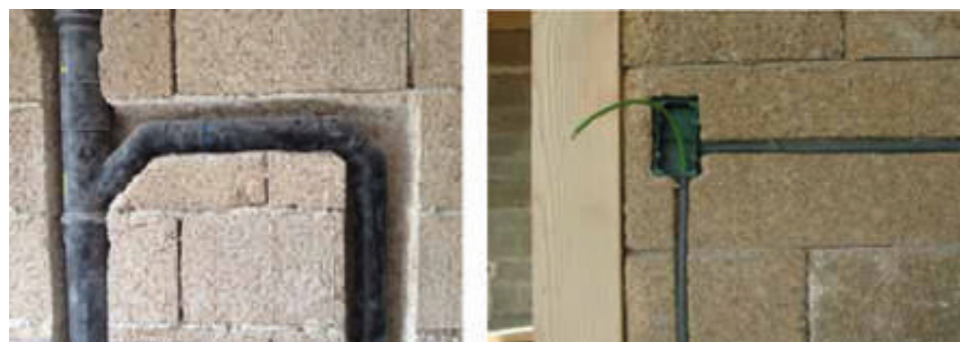
Traccia su Biomattone® per impianto sanitario
