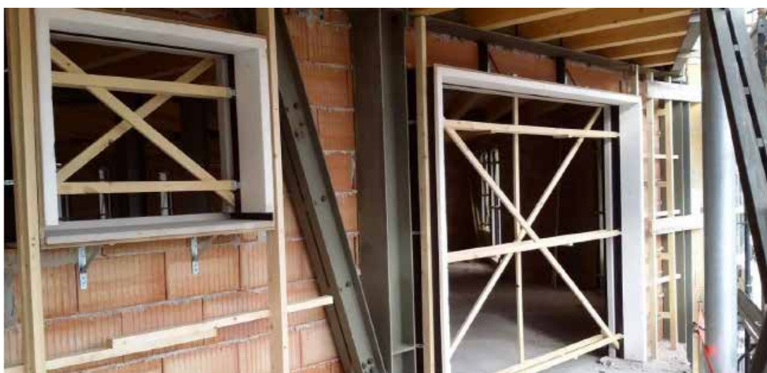
Posa in opera di contro-telai monoblocco con spallette in EPS forniti da Senini
