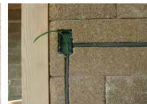
Traccia su Biomattone® per impianto elettrico
