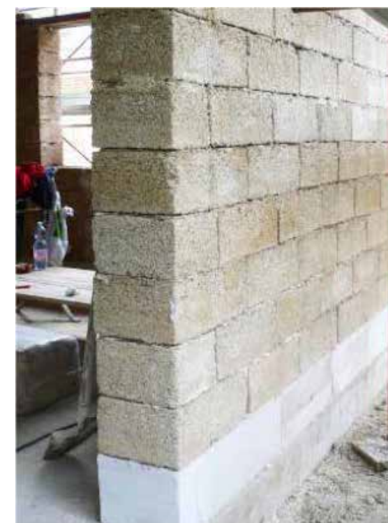
Isolamento del primo corso di Biomattone® con corso contro-terra in vetro cellulare
