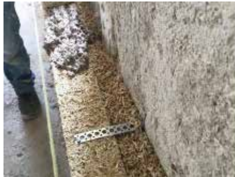
Vorsatzschale aus »Biomattone®« Klima-Hanfalksteinen mit Kerndämmung aus Biobeton®
