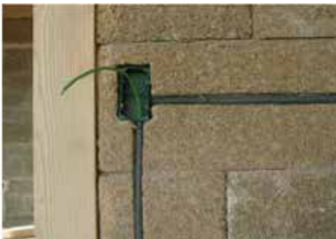
Leitungsschlitze für Elektroleitung
