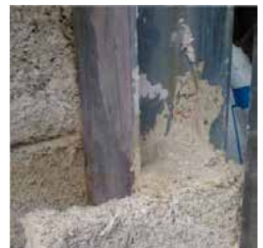
Zugeschnittenes »Biomattone®«-Formteil zur Wärmebrückenbeseitigung im Bereich Tragwerksanschluss
