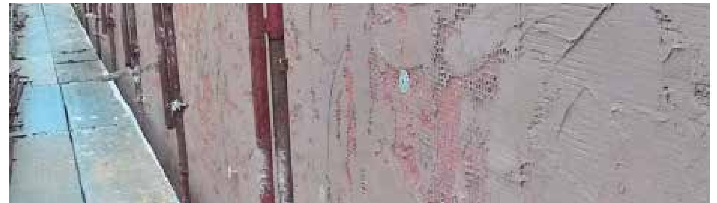
Erste Putzlage mit »Stabilitura Naturale Traspirante Plus« Kalksandputz und Armierungsgitter
