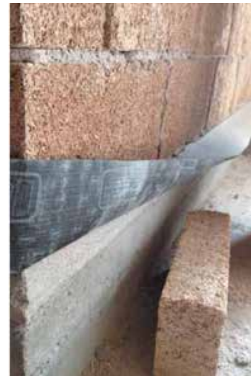
Abdichtung der ersten »Biomattone®«-Steinschicht mittels Dichtungsbahn
