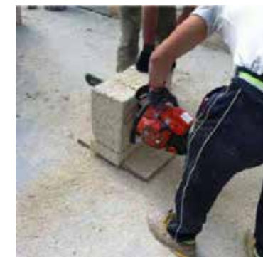
Zuschchnitt von »Biomattone®« mittels elektrischer Kettensäge
