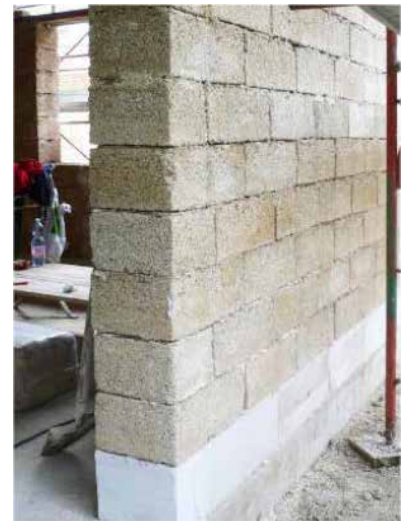
Abdichtung der ersten »Biomattone®«-Steinschicht mittels Dichtungsbahn
