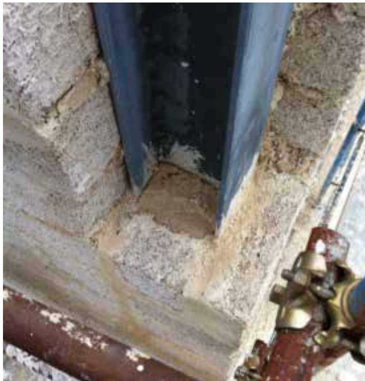
Stahltragwerk: Beseitigung einer Wärmebrücke im Bereich der Eckstütze mit passend zugeschnittenen »Biomattone®«-Hanfkalksteinen
