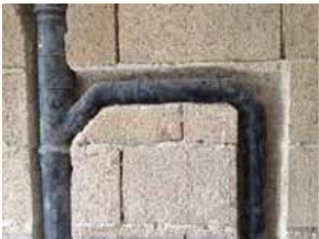
Leitungsschlitze für Rohrleitung
