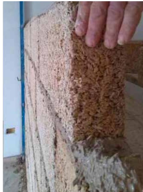
Vermauerung von »Biomattone®« Klima-Hanfalksteinen mit »MSC®« Stuktur-Kalkmörtel (2)
