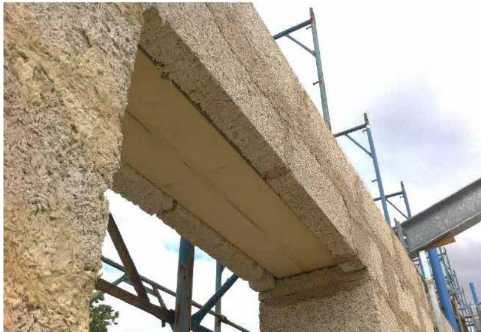
Einbaubeispiel Holzbalkensturz mit Wärmebrückenbeseitigung
