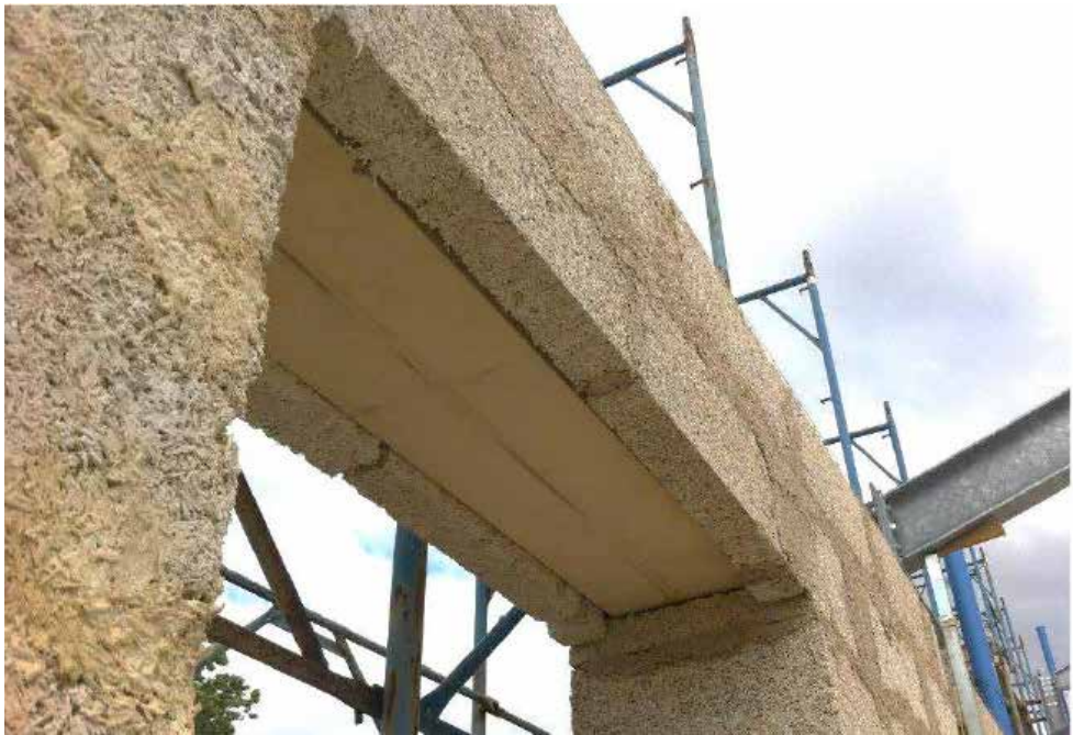
Pose d’un linteau en bois séché sur un mur en Biomattone® avec pont thermique supprimé
