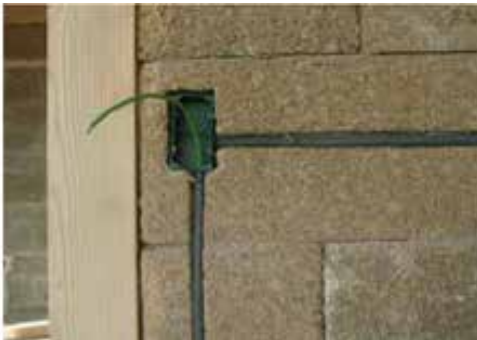
Saignée sur Biomattone® pour installation électrique
