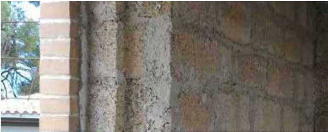
Façonnage du Biomattone® pour le logement du contre-châssis réalisé
