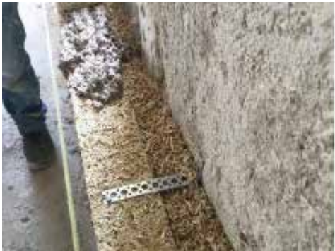
Contre-mur en Biomattone® avec vide rempli par Biobeton
