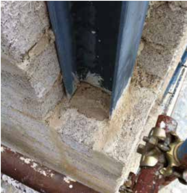
Charpente en acier : Résolution du pont thermique avec Biomattone® façonné au niveau de la colonne angulaire
