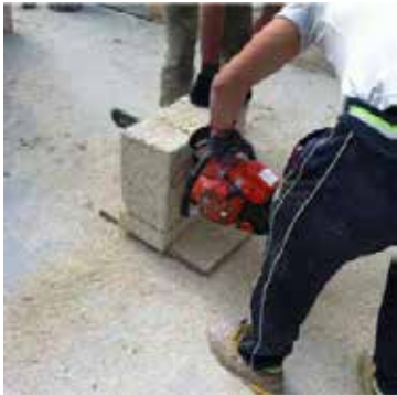
Coupe du Biomattone® avec scie électrique à chaîne
