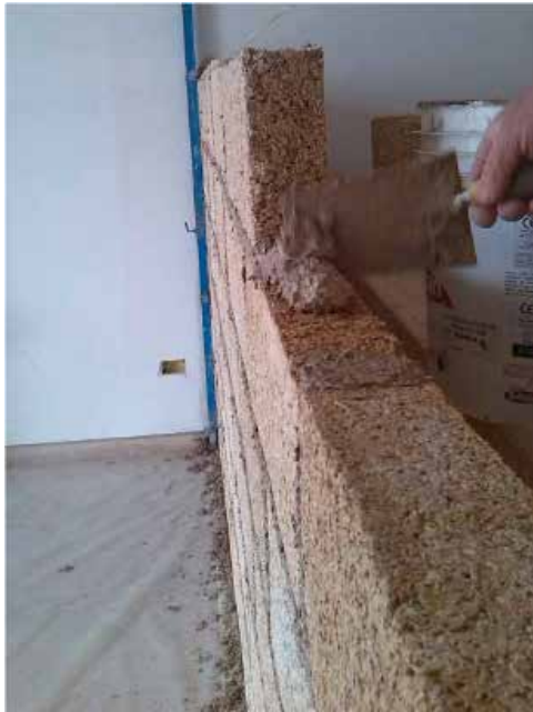
Pose du Biomattone® avec pose d'une couche de MSC® Malta Strutturale di Calce (Mortier structural à la chaux) (1)
