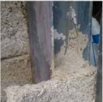
Biomattone® façonné utilisé pour supprimer le pont thermique au niveau de la charpente structurelle
