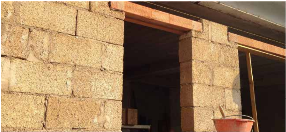
Pose d’un linteau en brique et béton sur un mur en Biomattone®
