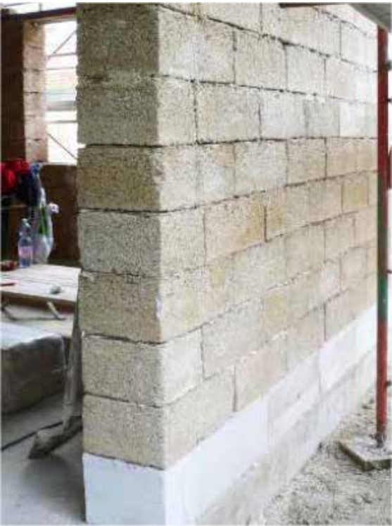
Aislamiento de la primera capa de Biomattone® con falso suelo de vidrio celular
