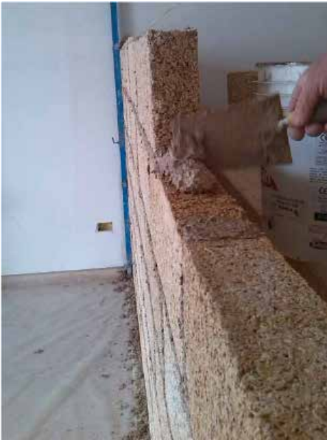
Instalación de Biomattone® con capa de base de mortero de cal estructural MSC® (1)
