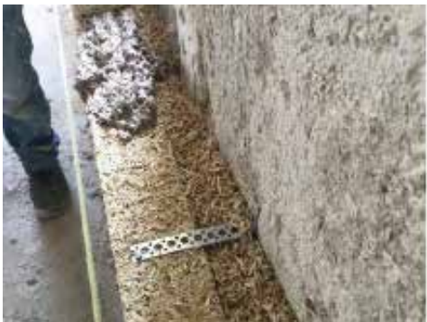
Falsa pared de Biomattone® con hueco relleno con Biobeton
