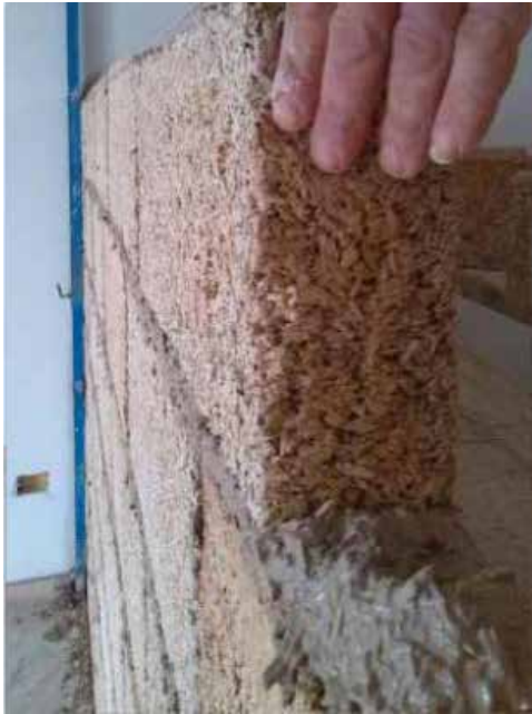
Instalación de Biomattone® con capa de base de mortero de cal estructural MSC® (2)
