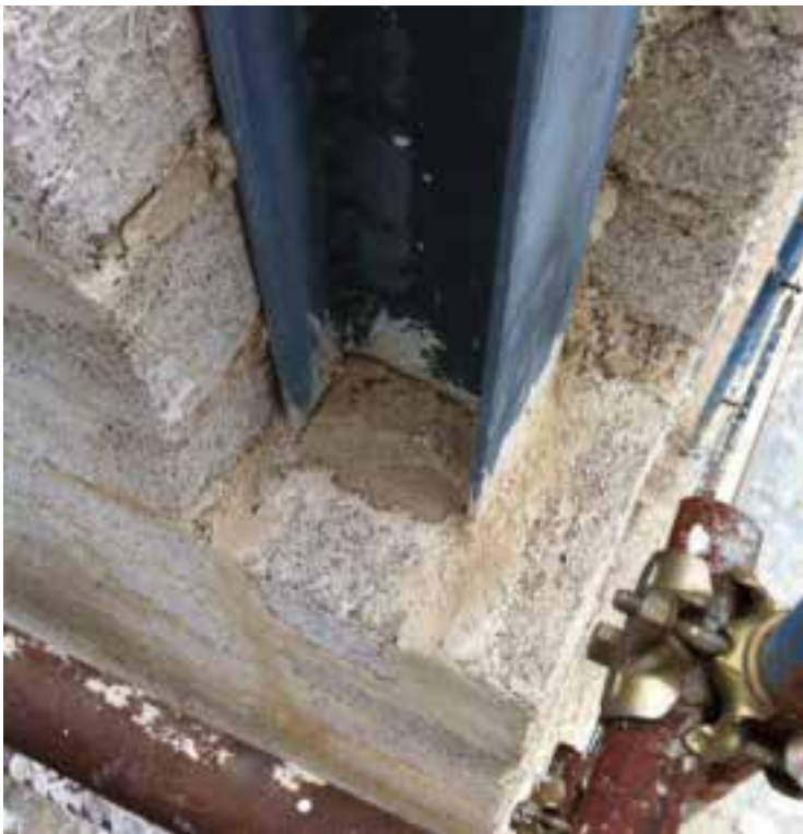
Marco de acero: Resolución puente térmico con Biomattone® moldeado cerca de la columna del borde
