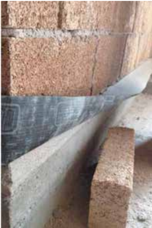
Aislamiento de la primera capa de Biomattone® con revestimiento impermeable
