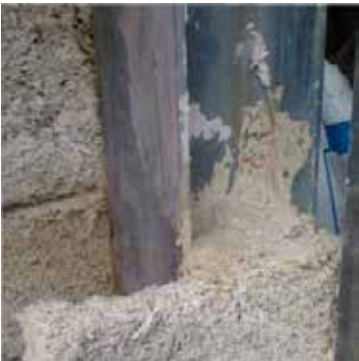
Biomattone® moldeado utilizado para resolver los puentes térmicos en la unión del marco estructural
