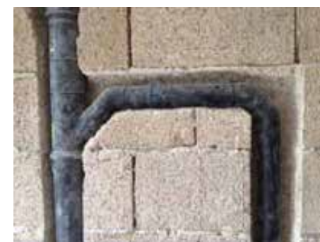
Traccia su Biomattone® per impianto sanitario
