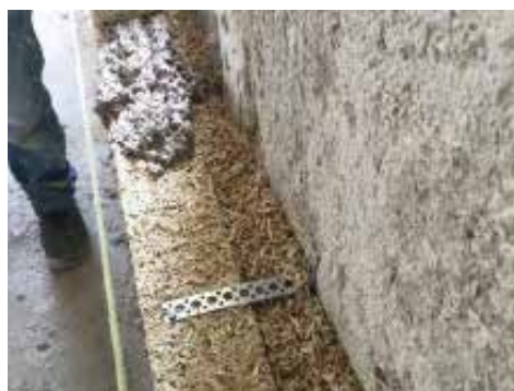
Controparete in Biomattone® con intercapedine riempita in Biobeton
