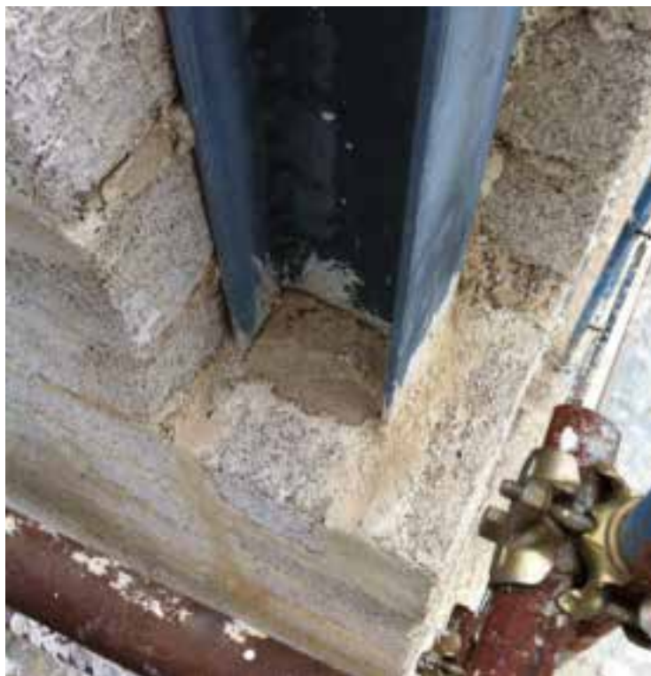
Telaio in acciaio: Risoluzione ponte termico con Biomattone® sagomato in corrispondenza di colonna d'angolo
