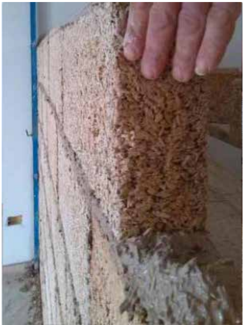
Posa in opera Biomattone® con stesura strato di allettamento in MSC® Malta Strutturale di Calce (2)
