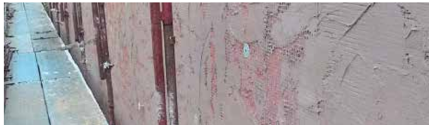
Apposizione rete da cappotto con stesura prima mano di Stabilitura Naturale Traspirante Plus.
