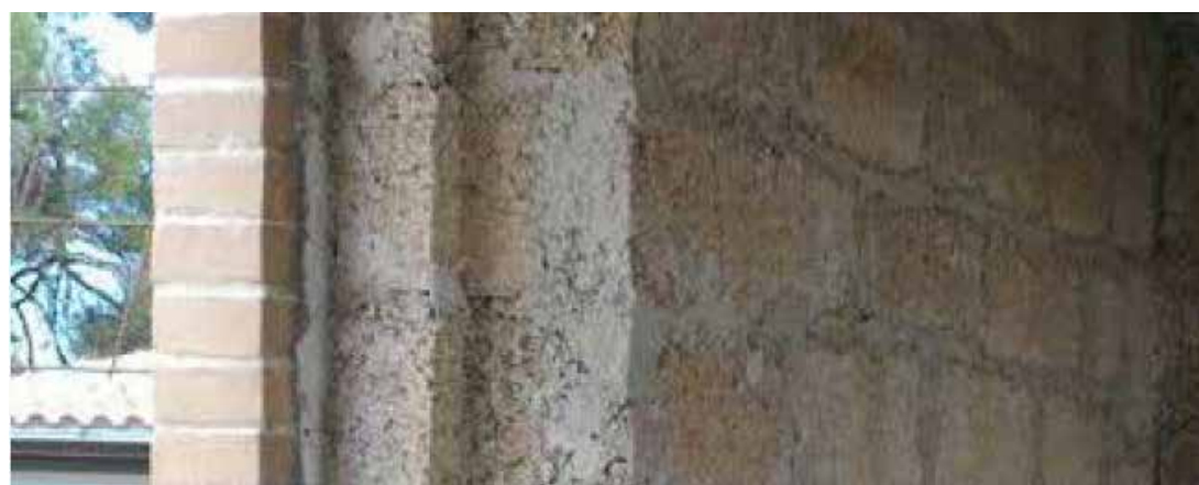
Sagomazione del Biomattone® per alloggiamento contro-telaio realizzato in opera
