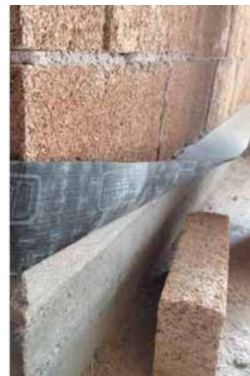
Isolamento del primo corso di Biomattone® con guaina impermeabile
