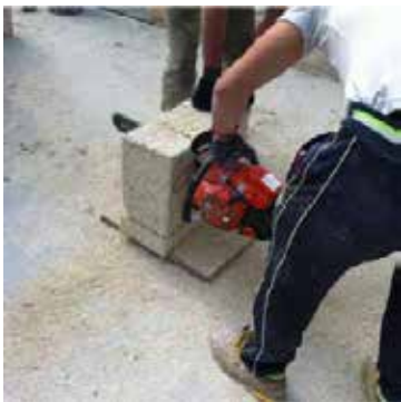
Taglio del Biomattone® con sega elettrica a catena
