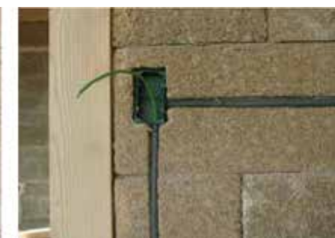
Traccia su Biomattone® per impianto elettrico
