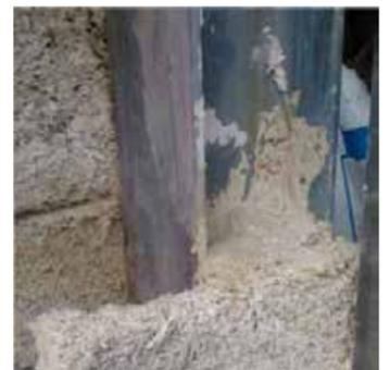
Biomattone® sagomato impiegato per risolvere ponte termico in corrispondenza del telaio strutturale
