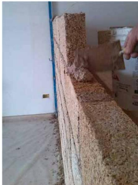
Posa in opera Biomattone® con stesura strato di allettamento in MSC® Malta Strutturale di Calce (1)
