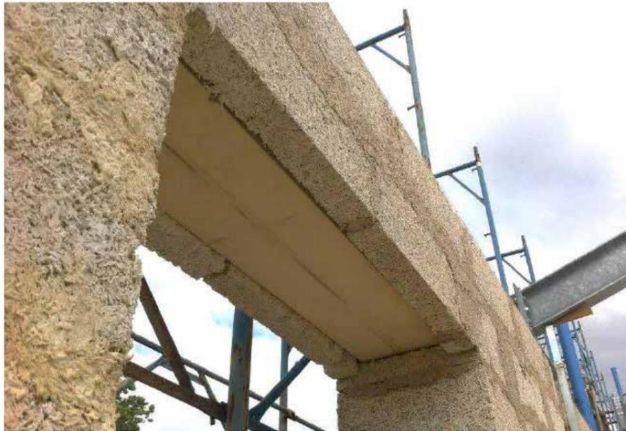
Posa in opera di architrave in legno essiccato su parete in Biomattone® con ponte termico risolto
