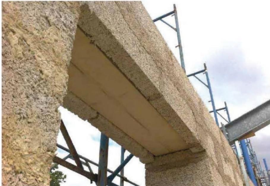
Einbaubeispiel Holzbalkensturz mit Wärmebrückenbeseitigung
