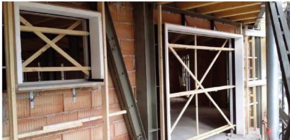
Ausbildung von Bauanschlusszargen in einschaligem Mauerwerk mit EPS-Auslaibungen von Senini
