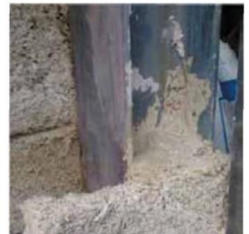
Zugeschnittenes »Blocco Ambiente®«-Formteil zur Wärmebrückenbeseitigung im Bereich Tragwerksanschluss
