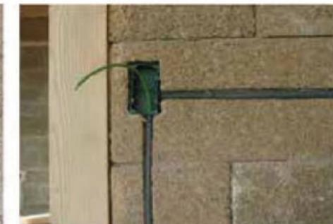
Leitungsschlitze für Elektroleitung
