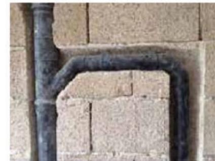
Leitungsschlitze für Rohrleitung
