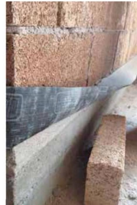
Abdichtung der ersten »Blocco Ambiente®«-Steinschicht mittels Dichtungsbahn
