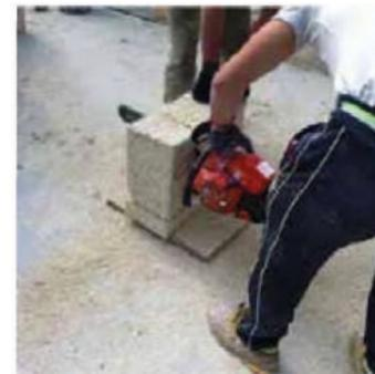
Zuschchnitt von »Blocco Ambiente®« mittels elektrischer Kettensäge
