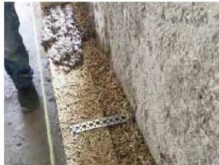
Vorsatzschale aus »Blocco Ambiente®« Klima-Hanfalksteinen mit Kerndämmung aus Biobeton®
