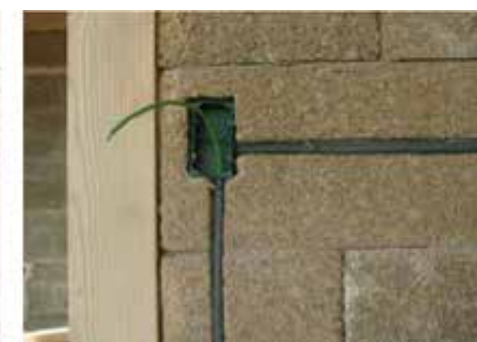
Traccia su Blocco Ambiente® per impianto elettrico
