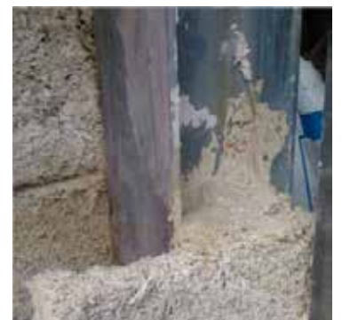
Blocco Ambiente® sagomato impiegato per risolvere ponte termico in corrispondenza del telaio strutturale
