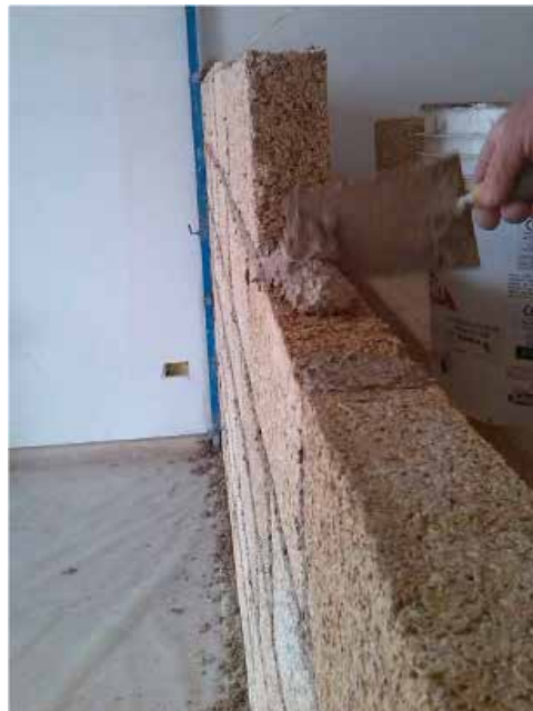
Posa in opera Blocco Ambiente® con stesura strato di allettamento in MSC® Malta Strutturale di Calce (1)
