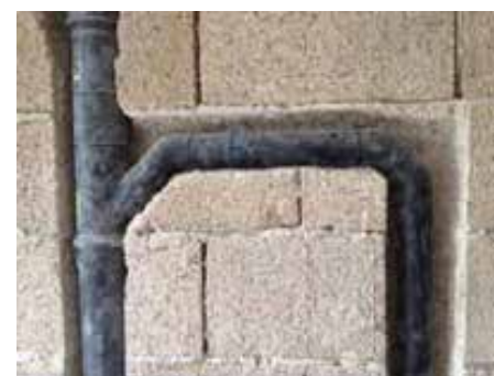
Traccia su Blocco Ambiente® per impianto sanitario
