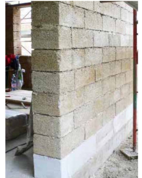
Isolation de la première couche de Blocco Ambiente® avec couche contre terre en verre cellulaire
