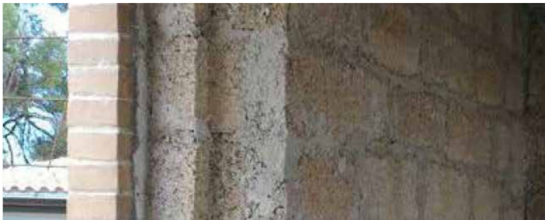
Façonnage du Blocco Ambiente® pour le logement du contre-châssis réalisé
