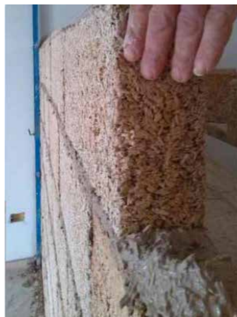
Pose de Blocco Ambiente® avec pose d'une couche de MSC® Malta Strutturale di Calce (Mortier structural à la chaux) (2)
