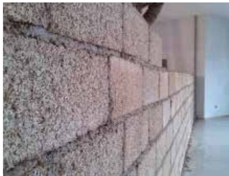
Mur de séparation interne en Blocco Ambiente®
