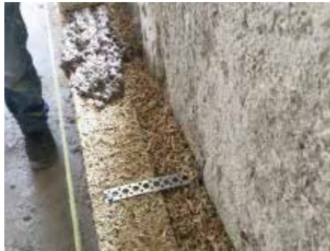
Contre-mur en Blocco Ambiente® avec vide rempli par Biobeton
