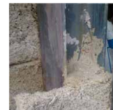
Blocco Ambiente® façonné utilisé pour supprimer le pont thermique au niveau de la charpente structurelle
