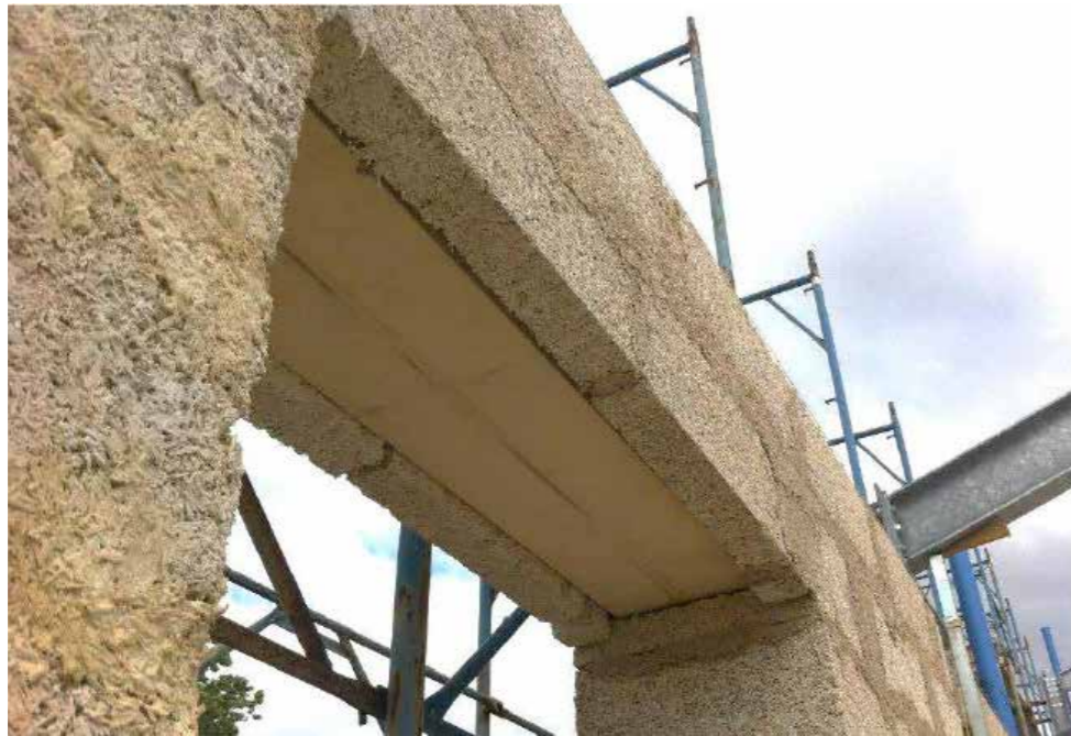
Pose d'un linteau en bois séché sur un mur en Blocco Ambiente® avec pont thermique supprimé
