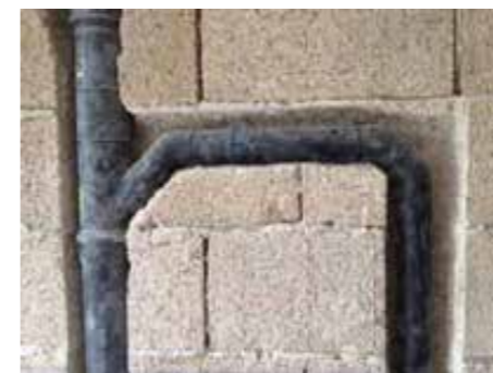
Saignée sur Blocco Ambiente® pour installation sanitaire
