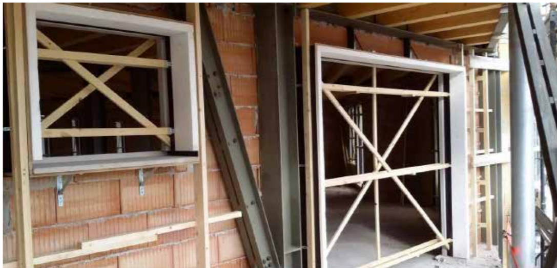
Pose de contre-châssis monobloc avec épaulements en PS fournis par Senini
