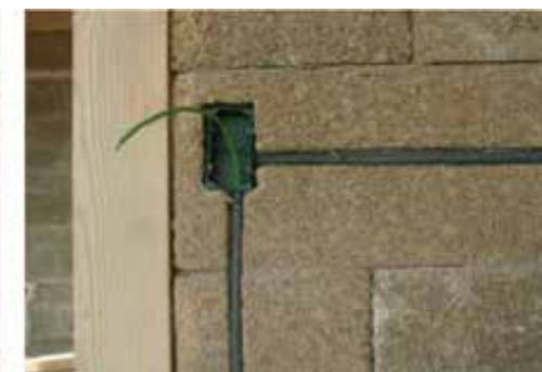
Saignée sur Blocco Ambiente® pour installation électrique
