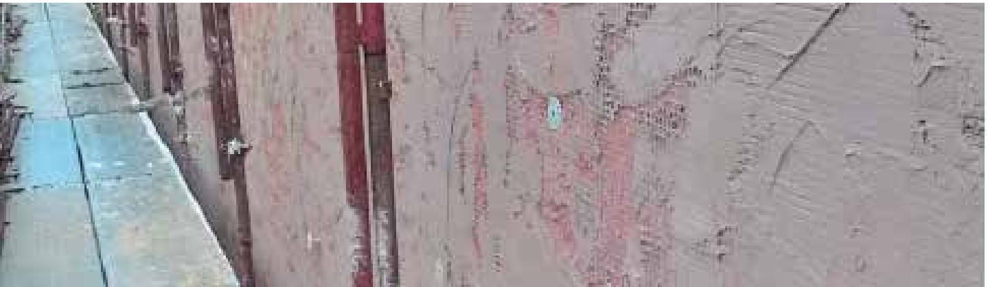
Colocación red de aislamiento con aplicación primera capa de Estabilizante Natural Transpirable Plus.
