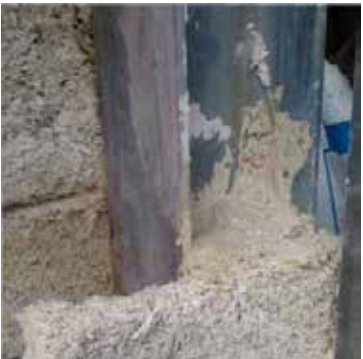
Blocco Ambiente® moldeado utilizado para resolver los puentes térmicos en la unión del marco estructural
