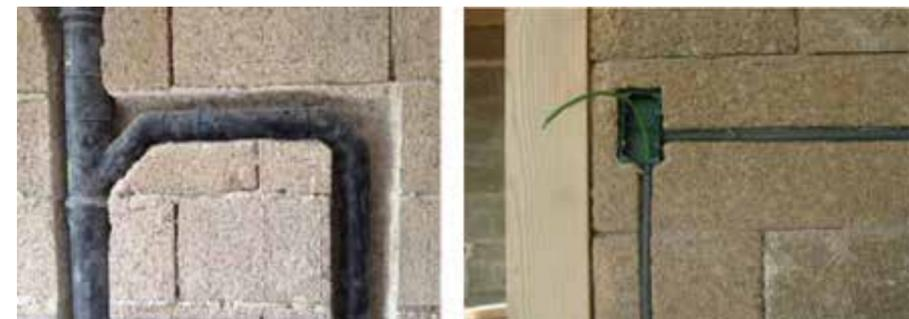
Traccia su Blocco Ambiente® per impianto sanitario Traccia su Blocco Ambiente® per impianto elettrico
