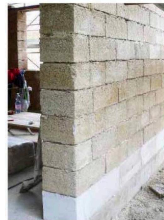
Abdichtung der ersten »Blocco Ambiente®«-Steinschicht mittels Dichtungsbahn
