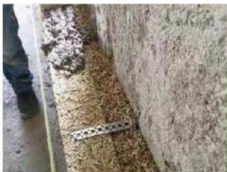
Vorsatzschale aus »Blocco Ambiente®« Klima-Hanfalksteinen mit Kerndämmung aus Biobeton®
