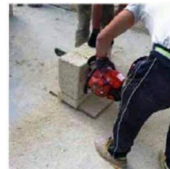
Zuschnitt von »Blocco Ambiente®« mittels elektrischer Kettensäge
