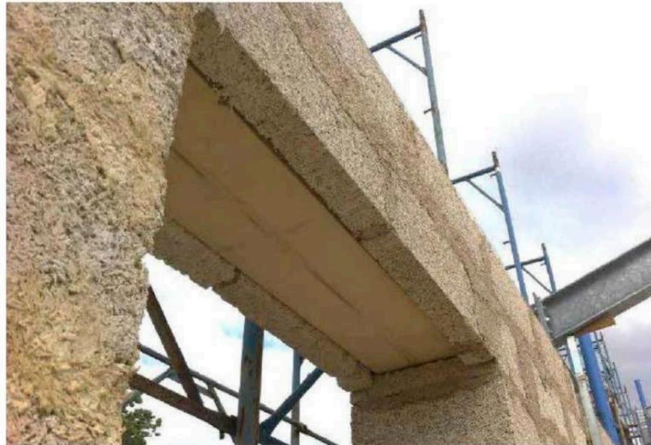
Einbaubeispiel Holzbalkensturz mit Wärmebrückenbeseitigung
