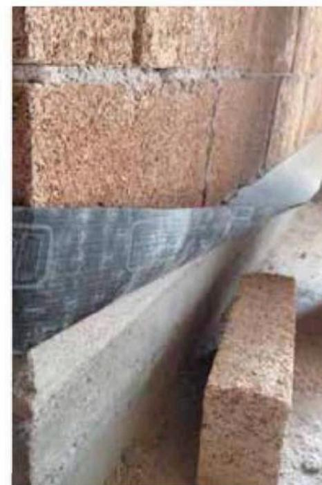
Abdichtung der ersten »Blocco Ambiente®«-Steinschicht mittels Dichtungsbahn
