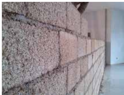
Internal partition of Blocco Ambiente®
