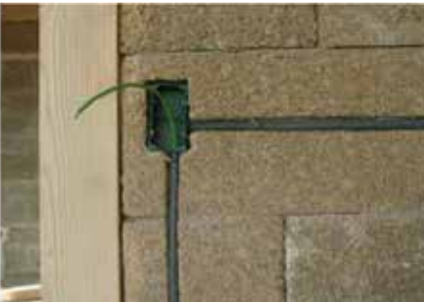
Saignée sur Blocco Ambiente® pour installation électrique
