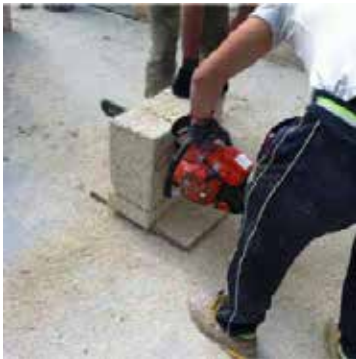
Corte del Blocco Ambiente® con sierra eléctrica de cadena
