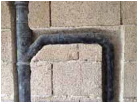
Saignée sur Blocco Ambiente® pour installation sanitaire
