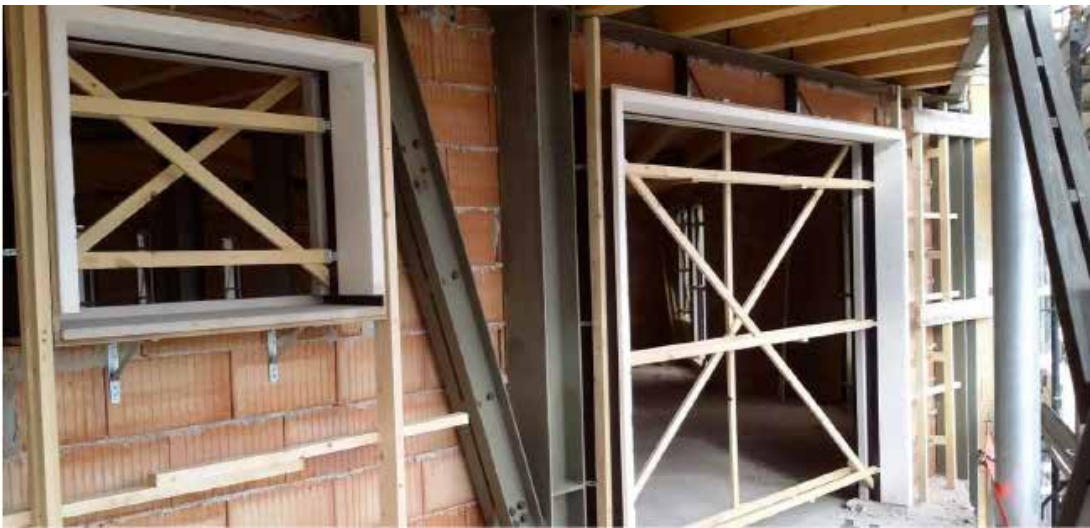
Pose de contre-châssis monobloc avec épaulements en PS fournis par Senini
