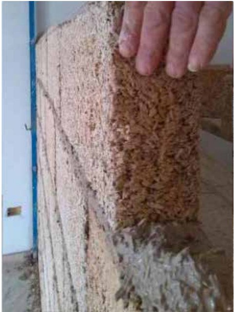
Pose de Blocco Ambiente® avec pose d'une couche de MSC® Malta Strutturale di Calce (Mortier structurel à la chaux) (2)
