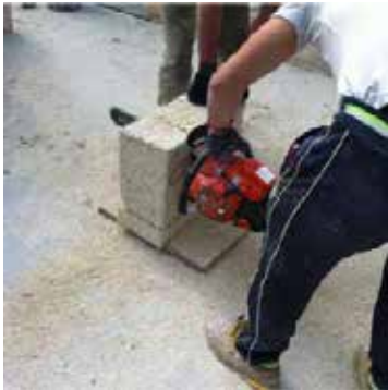
Coupe du Blocco Ambiente® avec scie électrique à chaîne
