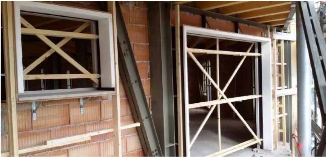
Instalación de contramarcos monobloque con soportes EPS suministrados por Senini
