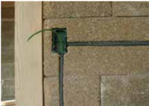
Vía en Blocco Ambiente® para instalación eléctrica
