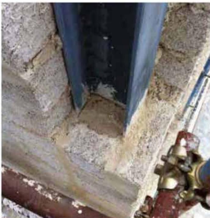
Stahltragwerk: Beseitigung einer Wärmebrücke im Bereich der Eckstütze mit passend zugeschnittenen »Blocco Ambiente®«-Hanfalksteinen
