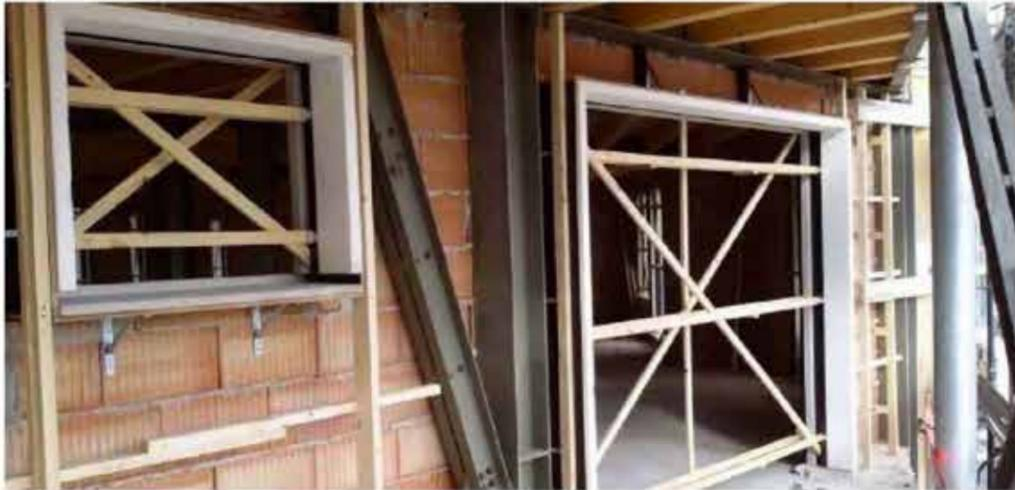
Ausbildung von Bauanschlusszargen in einschalligem Mauerwerk mit EPS-Auslaibungen von Senini
