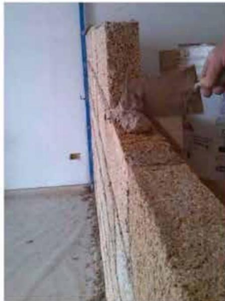
Vermauerung von »Blocco Ambiente®« Klima-Hanfalksteinen mit »MSC®« Struktur-Kalkmörtel (1)
