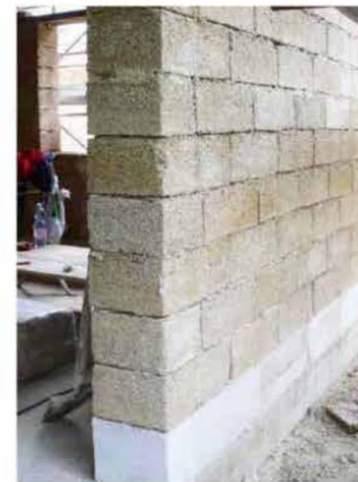
Abdichtung der ersten »Blocco Ambiente®«-Steinschicht mittels Dichtungsbahn
