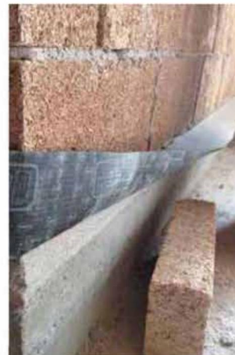
Abdichtung der ersten »Blocco Ambiente®«-Steinschicht mittels Dichtungsbahn
