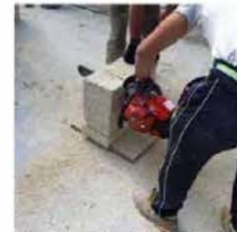
Zuschneidung von »Blocco Ambiente®« mittels elektrischer Kettensäge
