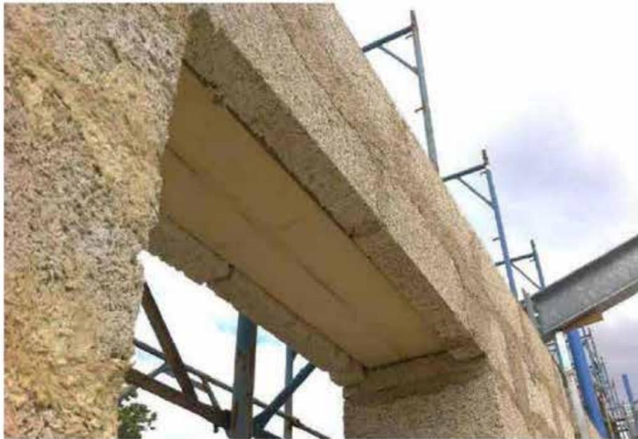
Einbaubeispiel Holzbalkensturz mit Wärmebrückenbeseitigung
