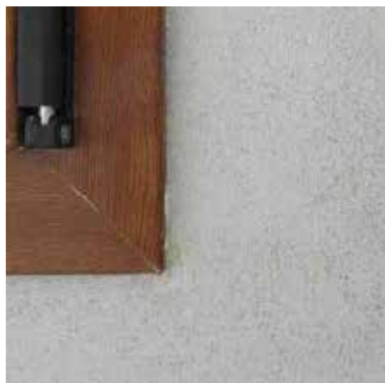
Stabilitura esterna al finito
