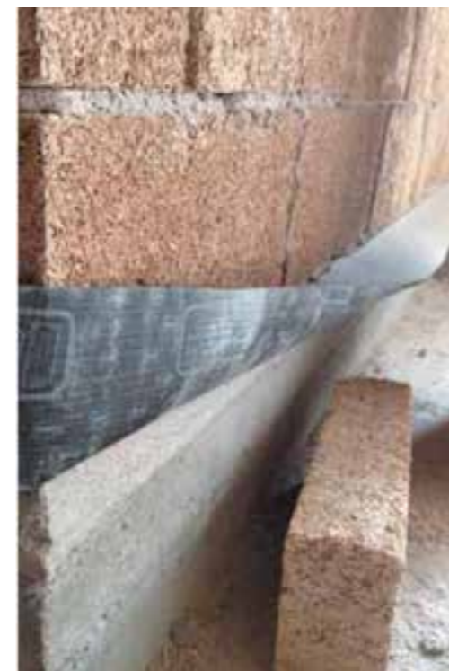
Isolamento del primo corso di Blocco Ambiente® con guaina impermeabile
