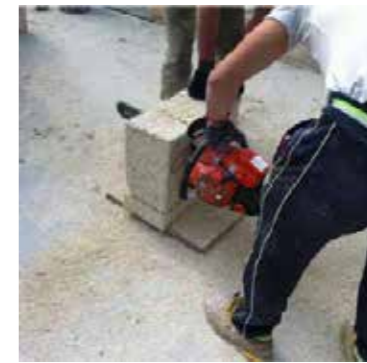
Taglio del Blocco Ambiente® con sega elettrica a catena
