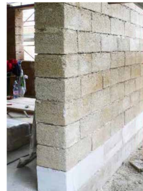
Isolamento del primo corso di Blocco Ambiente® con corso contro-terra in vetro cellulare
