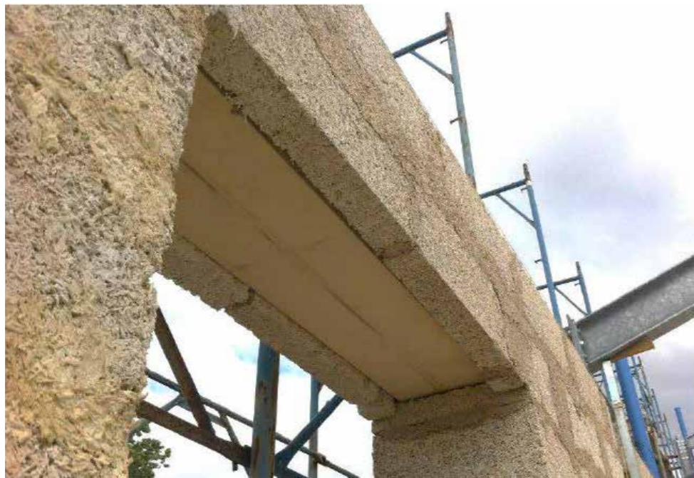
Posa in opera di architrave in legno essiccato su parete in Blocco Ambiente® con ponte termico risolto
