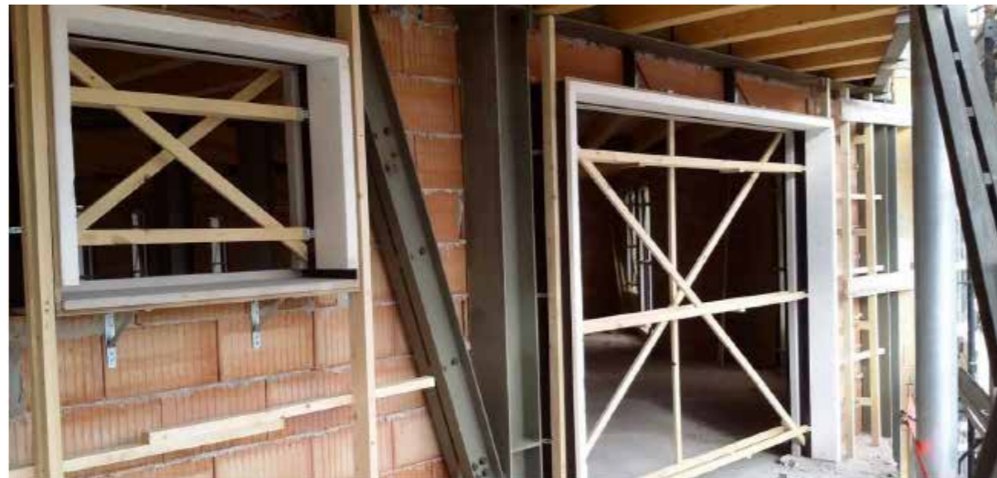
Posa in opera di contro-telai monoblocco con spallette in EPS forniti da Senini
