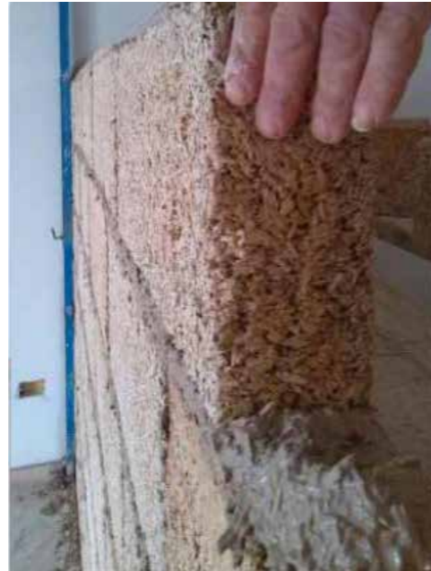
Posa in opera Blocco Ambiente® con stesura strato di allettamento in MSC® Malta Strutturale di Calce (2)
