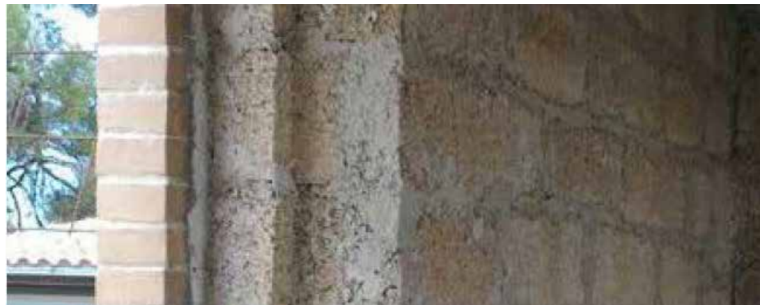
Sagomazione del Blocco Ambiente® per alloggiamento contro-telaio realizzato in opera
