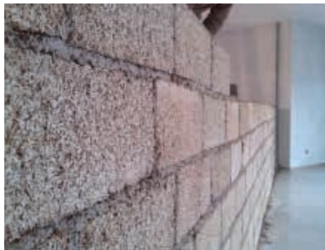
Mur de séparation interne en Blocco Ambiente®
