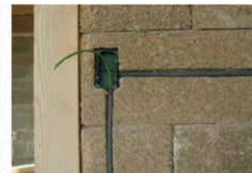
Saignée sur Blocco Ambiente® pour installation électrique
