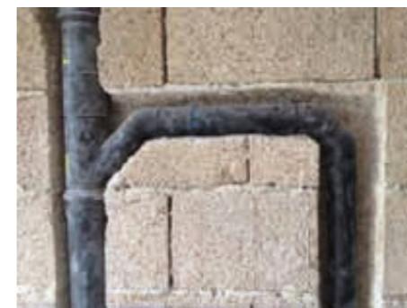
Saignée sur Blocco Ambiente® pour installation sanitaire
