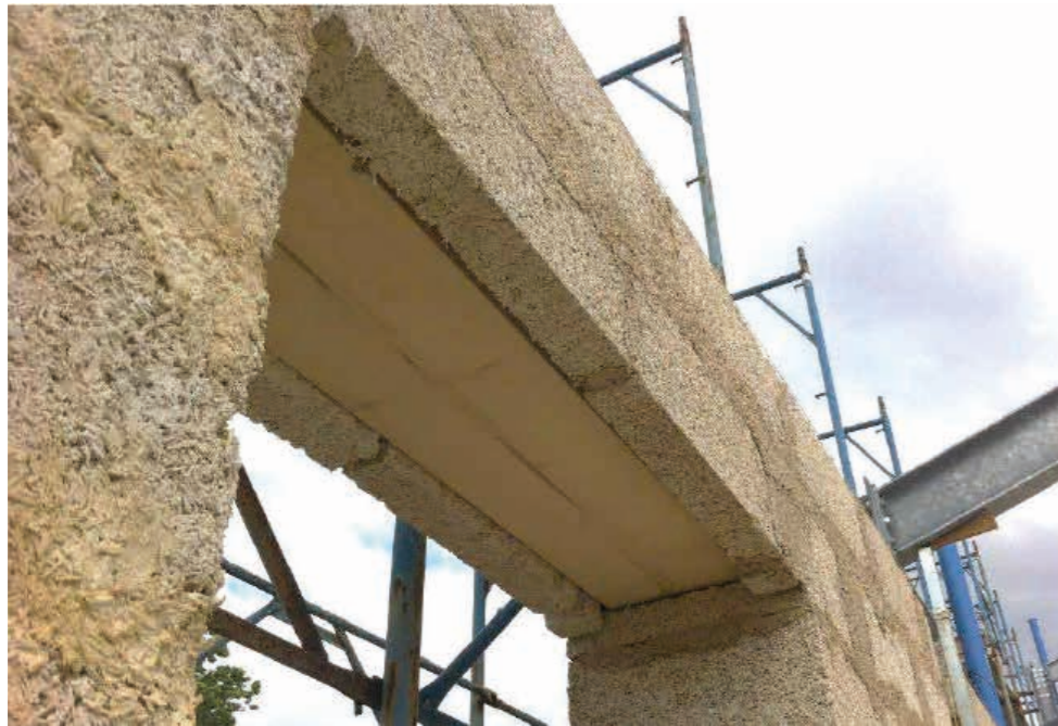
Pose d'un linteau en bois séché sur un mur en Blocco Ambiente® avec pont thermique supprimé
