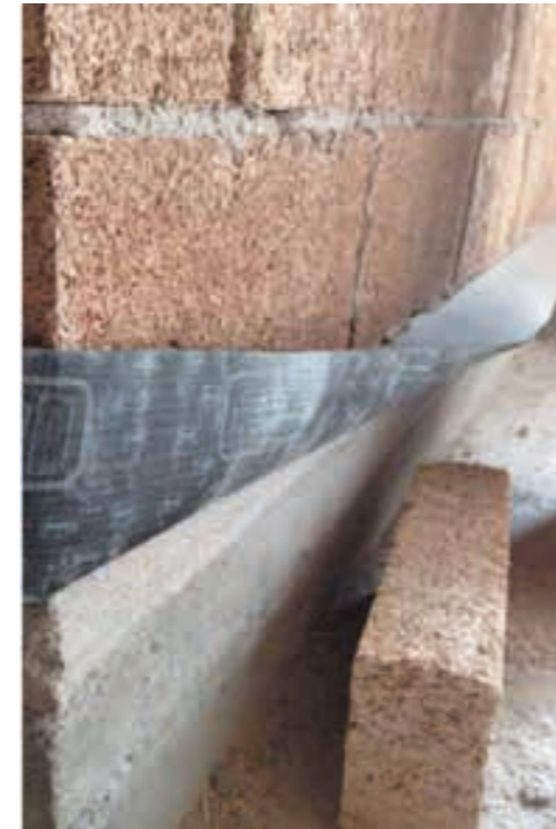
Isolation de la première couche de Blocco Ambiente® avec gaine étanche
