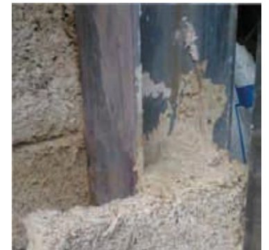
Blocco Ambiente® façonné utilisé pour supprimer le pont thermique au niveau de la charpente structurelle
