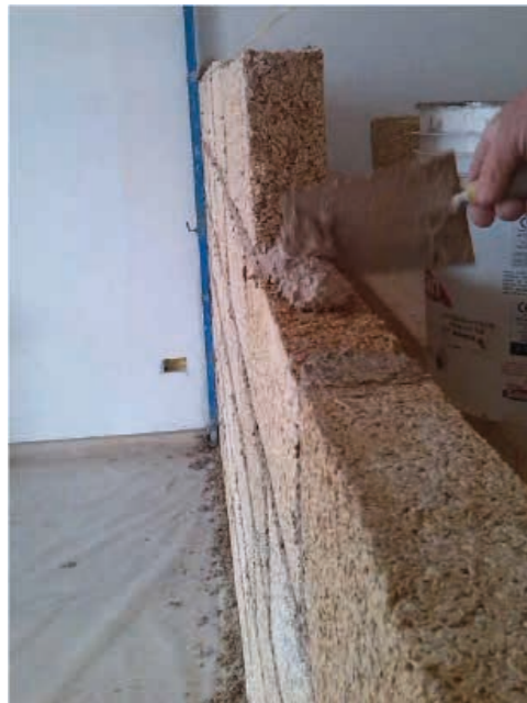
Pose du Blocco Ambiente® avec pose d'une couche de MSC® Malta Strutturale di Calce (Mortier structural à la chaux) (1)
