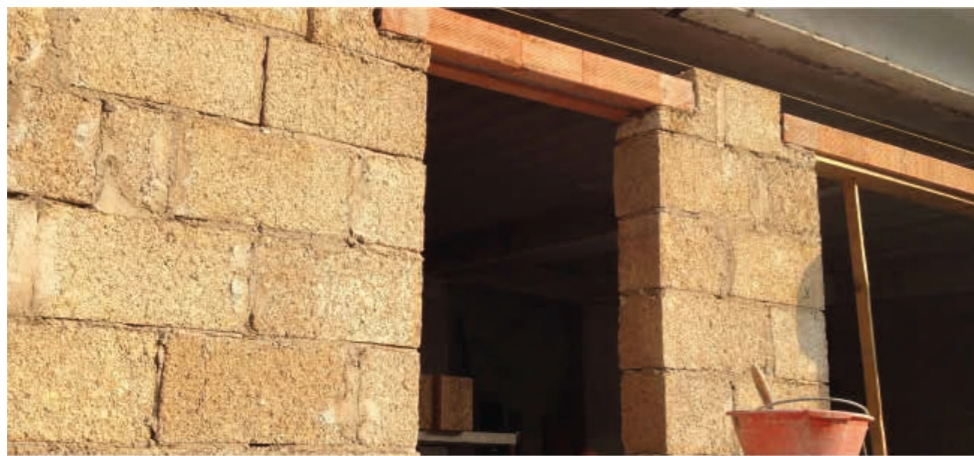
Pose d'un linteau en brique et béton sur un mur en Blocco Ambiente®
