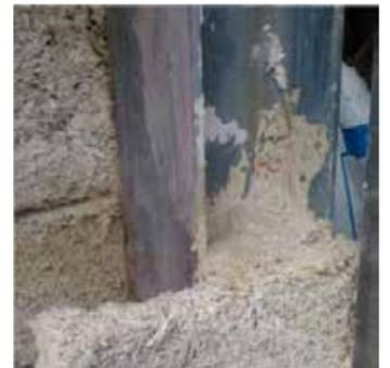
Blocco Ambiente® moldeado utilizado para resolver los puentes térmicos en la unión del marco estructural
