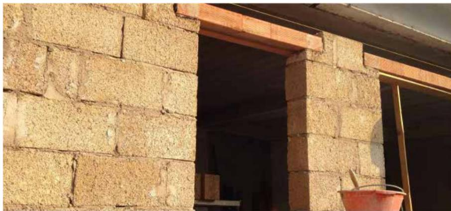
Instalación de un dintel de ladrillo común en una pared de Blocco Ambiente®
