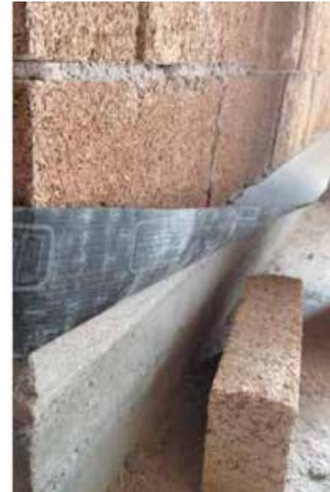
Aislamiento de la primera capa de Blocco Ambiente® con revestimiento impermeable
