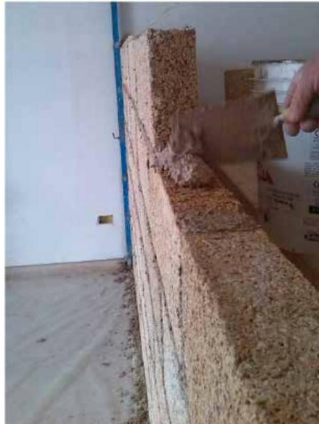
Instalación de Blocco Ambiente® con capa de base de mortero de cal estructural MSC® (1)
