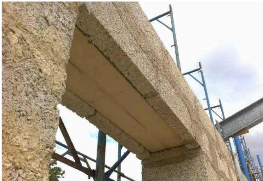
Instalación de un dintel de madera seca sobre pared de Blocco Ambiente® con puente térmico resuelto
