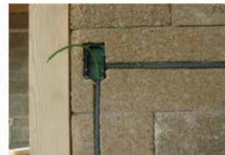
Vía en Blocco Ambiente® para instalación eléctrica
