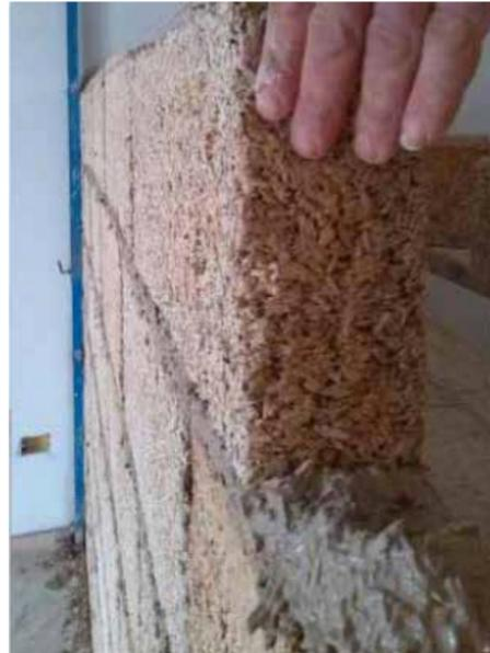
Instalación de Blocco Ambiente® con capa de base de mortero de cal estructural MSC® (2)
