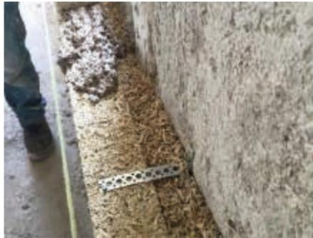
Falsa pared de Blocco Ambiente® con hueco relleno con Biobeton
