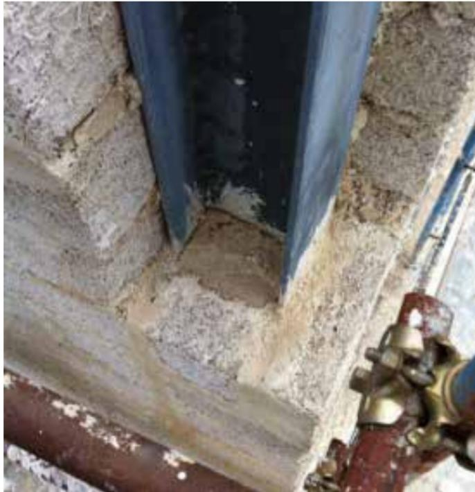
Marco de acero: Resolución puente térmico con Blocco Ambiente® moldeado cerca de la columna del borde
