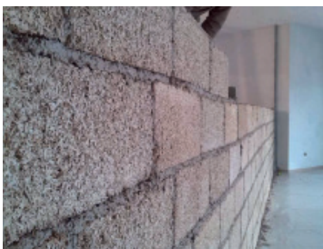
Internal partition of Blocco Ambiente ®
