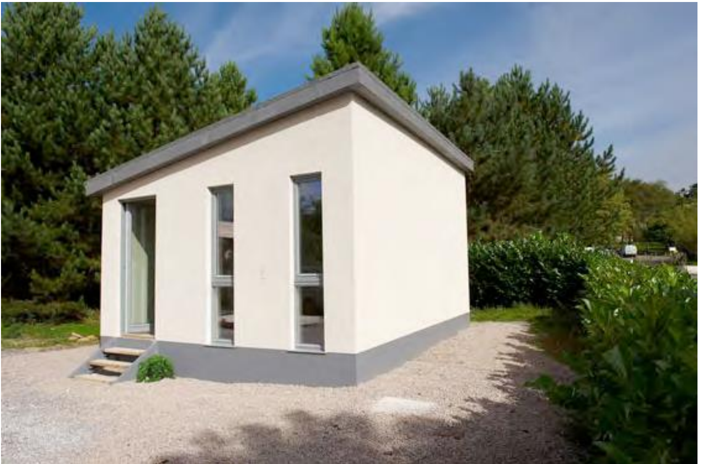
Figura 1: edificio sperimentale in canapa-calce (HemPod) dell'Università di Bath
