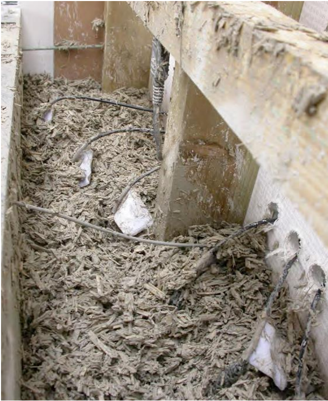
Figura 3: sensori incorporati nella parete in canapa-calce durante la costruzione
