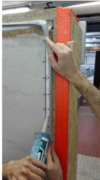
Figura 5: Posa del silicone sigillante
