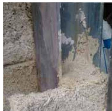
Blocco Ambiente® sagomato impiegato per risolvere ponte termico in corrispondenza del telaio strutturale
