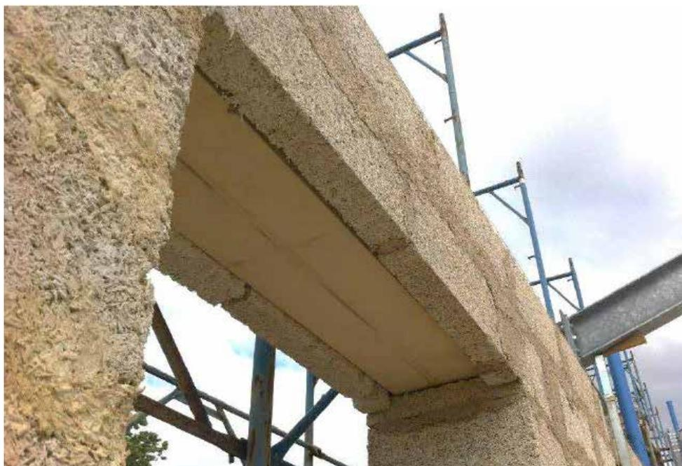
*Posa in opera di architrave in legno essiccato su parete in Blocco Ambiente® con ponte termico risolto*
